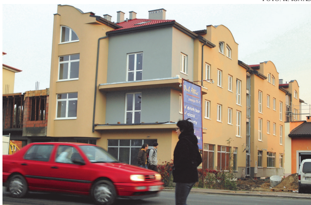
Budynek w którym ma powstać prywatna przychodnia, jest na etapie wykańczania.
